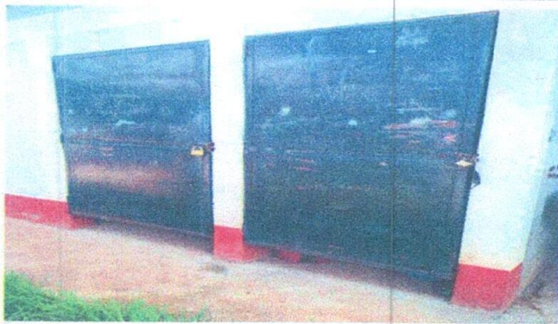
Foto 1: Sustrucción de puerta en servicios sanitarios
