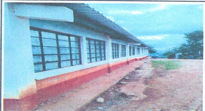
Foto 2: Balcones de ventanas
