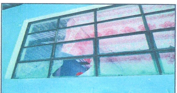
Foto 6: Sustitución de Vidrios
