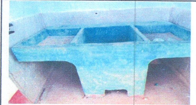
Foto1: Sustitución de Pila plástica de dos lavaderos
